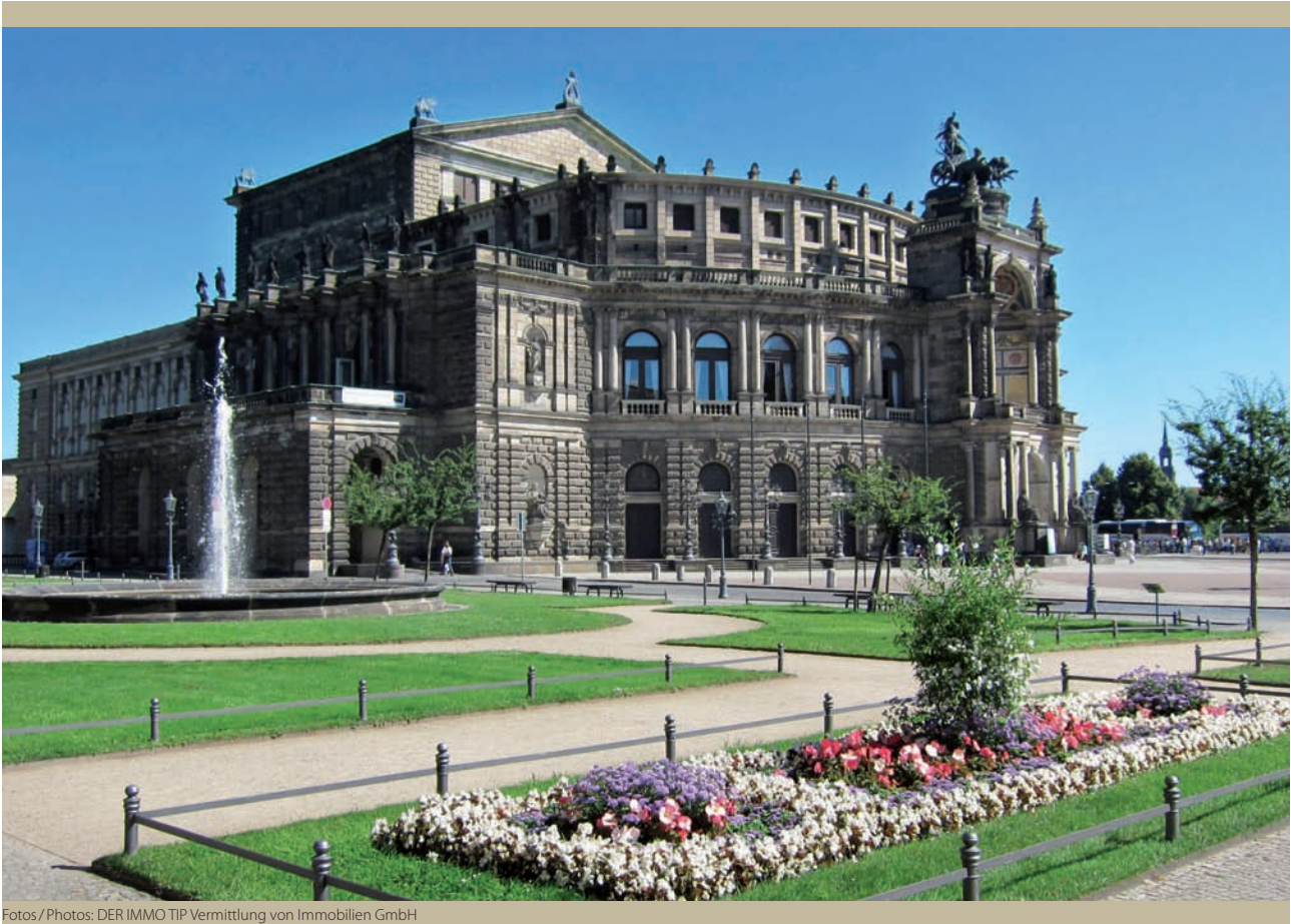
Fotos/Photos: DER IMMO TIP Vermittlung von Immobilien GmbH
