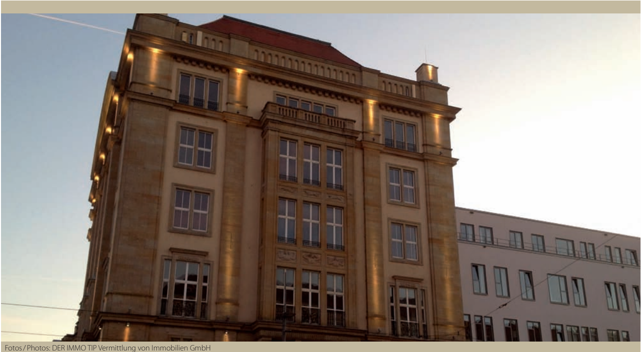
Fotos/Photos: DER IMMO TIP Vermittlung von Immobilien GmbH
